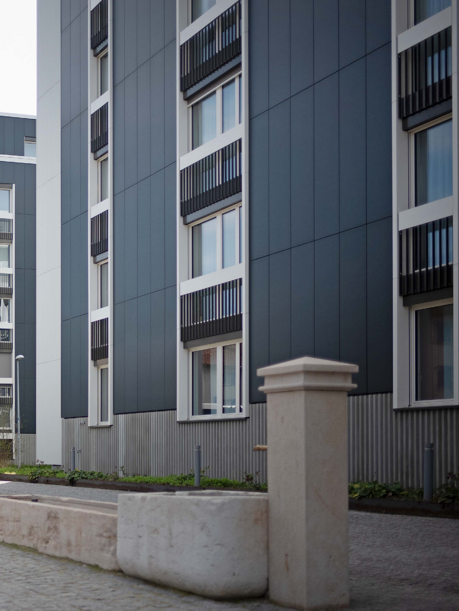
Die Fassade und das Dach der Siedlung Allschwil der Graphis Bau- und Wohngenossenschaft sind vollständig mit Photovoltaik ausgestattet. La façade et le toit du lotissement d'Allschwil de la Coopérative de construction et d'habitation Graphis sont entièrement équipés de panneaux photovoltaïques.
